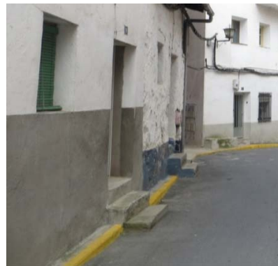
Invasión de la calzada
