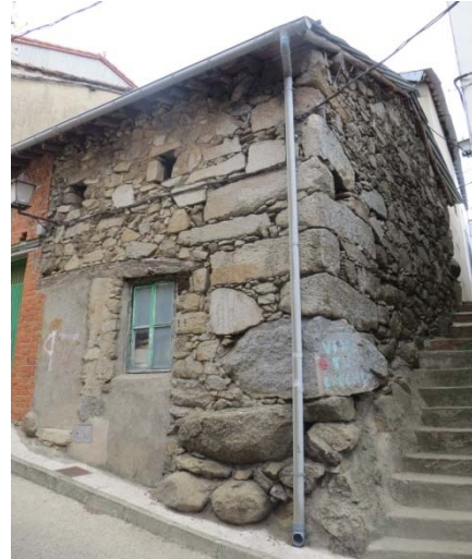
Empleo de grandes bloques de granito en esquinas.
