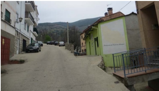
Accesos volados a la edificación
