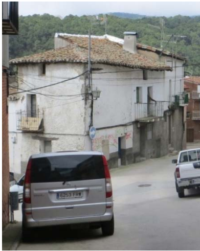
La altura de estas edificaciones aumenta y el doblado tradicional, presenta huecos de ventilación mayores
