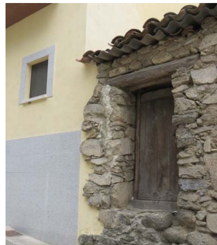
Huecos de fachada con cargadero de madera y carpintería de tablones del mismo material
