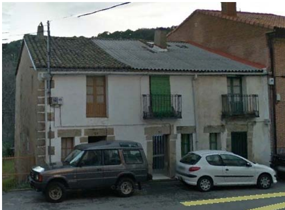
Los huecos se recercan con piedras escuadradas, como también las esquinas. Aparecen balcones de forja y carpinterías con cuarterones.
