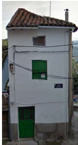
La altura de estas edificaciones aumenta y el doblado tradicional, presenta huecos de ventilación mayores
