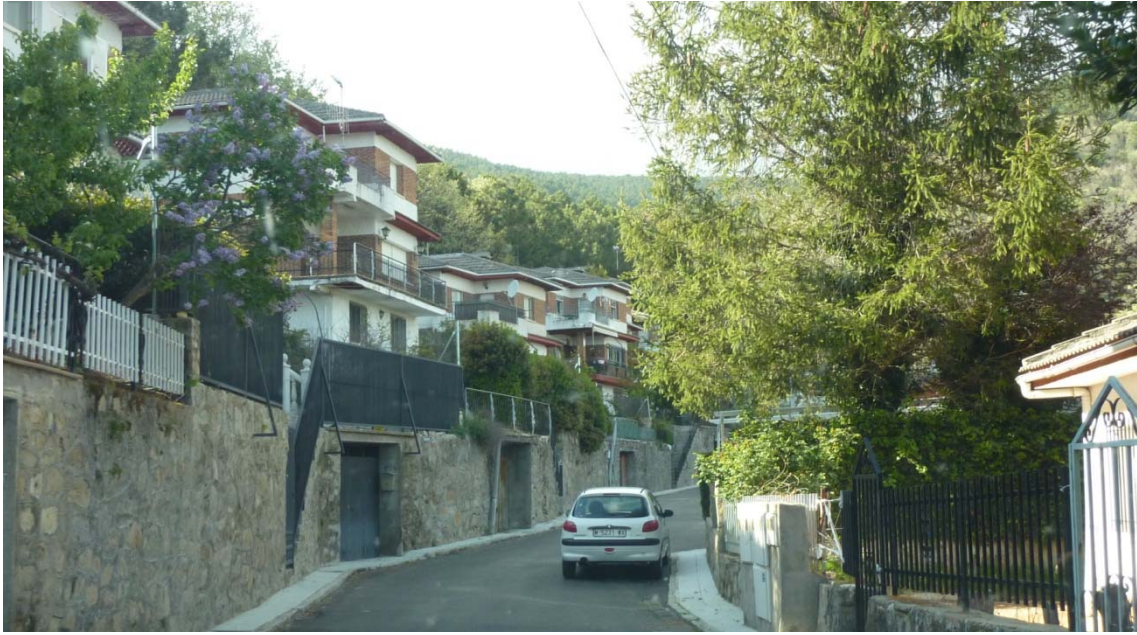
Los elementos de la urbanización proporcionan una imagen armónica del conjunto, aunque muy alejada de las características de la arquitectura vernácula de la comarca.
