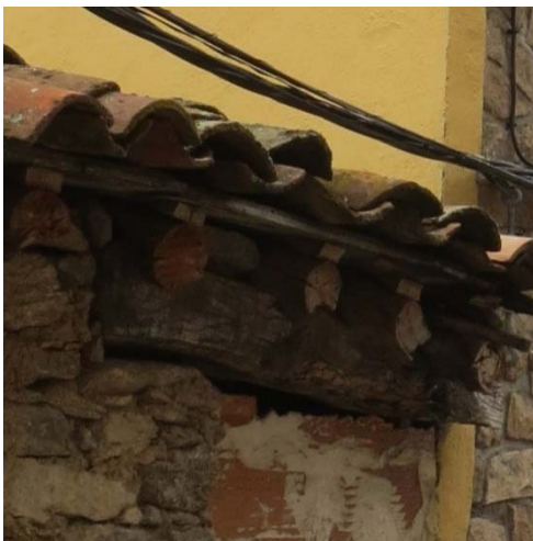
Estructura de cubierta de rollizos de madera y teja cerámica curva
