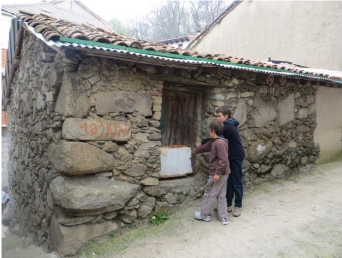
Empleo de grandes bloques de granito en esquinas.
