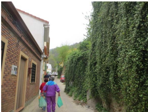
Configuración asimétrica de las fachadas por la presencia de muros que salvan el desnivel.
