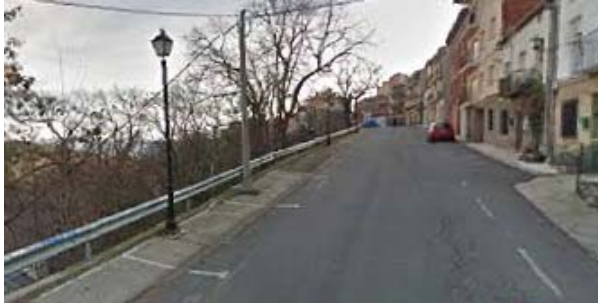
Tramo de travesía en el borde este
