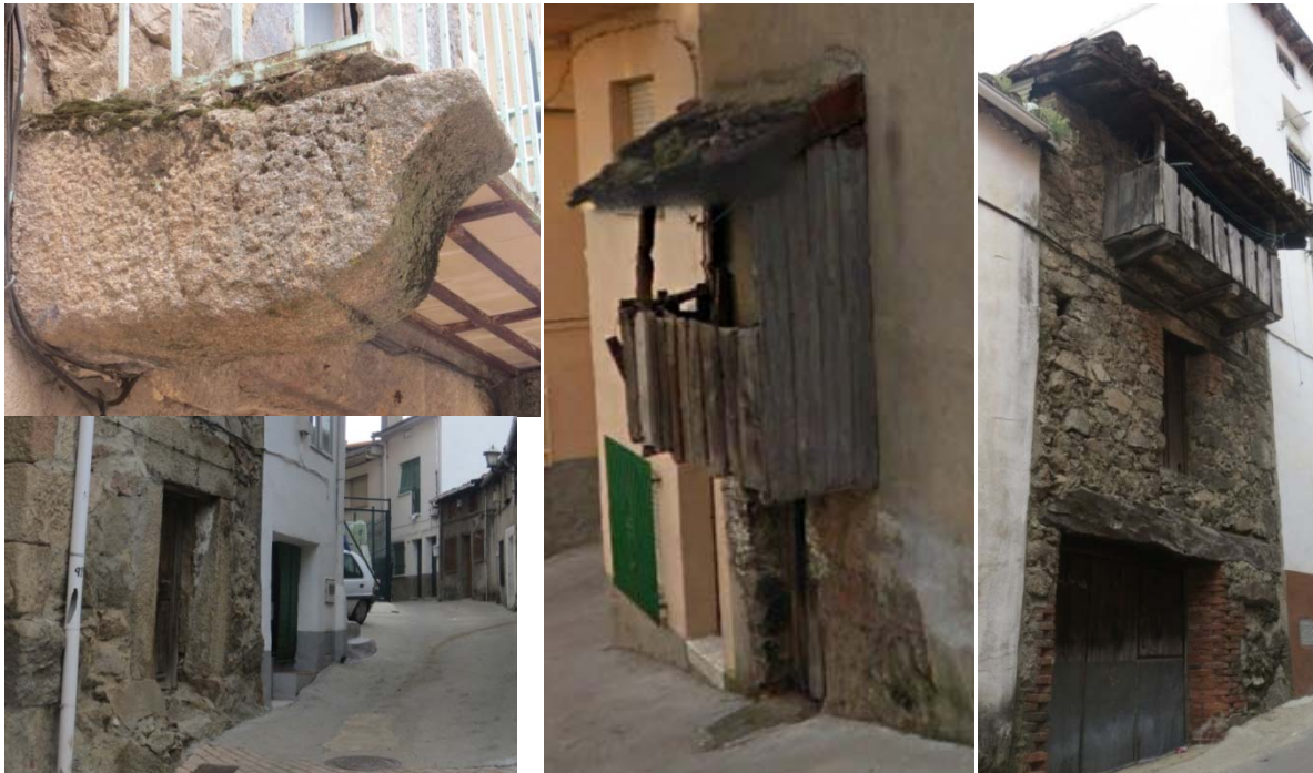
Elementos singulares. De izquierda a derecha: ménsula de piedra; cuerpos volados de madera; cimentación de roca granítica.
